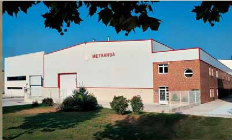
Vista exterior de nuestras instalaciones
